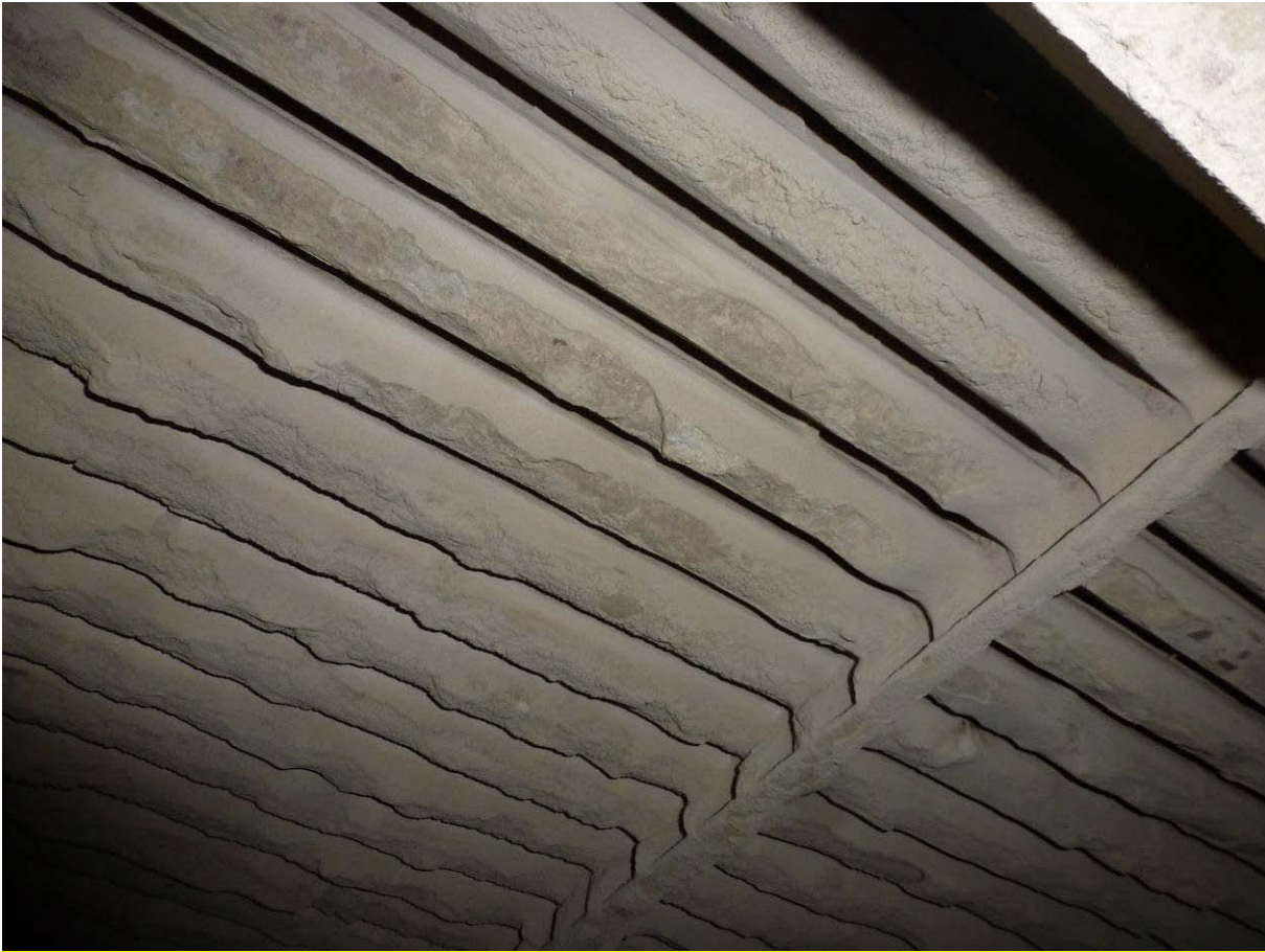
Bild 2: TÖ-ECO (von unten) aus einer anderen Anlage, die korrekt betrieben wird. Nur Staub auf zur Abreinigung abgewandten Seite, Gassen sind ganz offen. Ansicht nach einem Jahr Dauerbetrieb.
